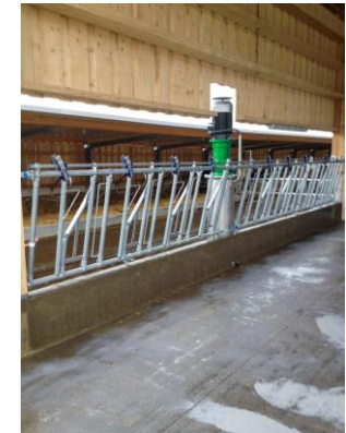
Canaux équipés de vannes dans une stabulation pour éviter aux gaz de pénétrer dans l'étable
